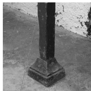
Detalle de uno de los pilares del patio.
