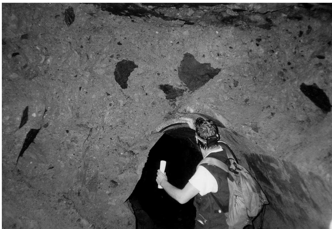
Galería de agua atravesando el 'mortalón' o 'fanglomerado'.
