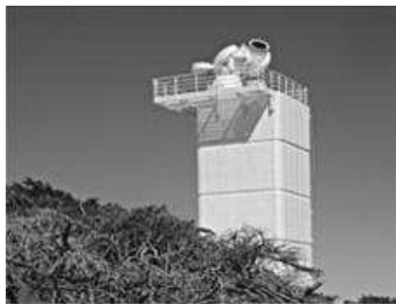
Fig. 21. Torre Solar Sueca.
