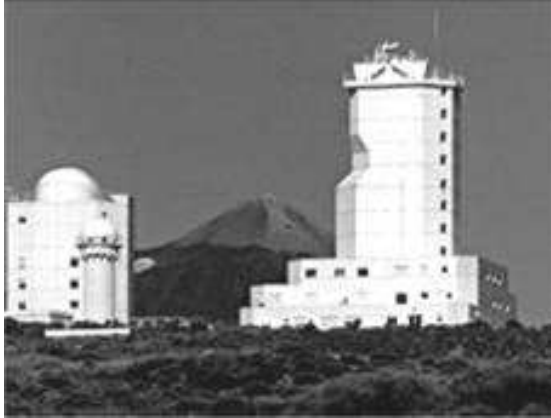
Fig. 27. Torre de Vacío (VTT).
