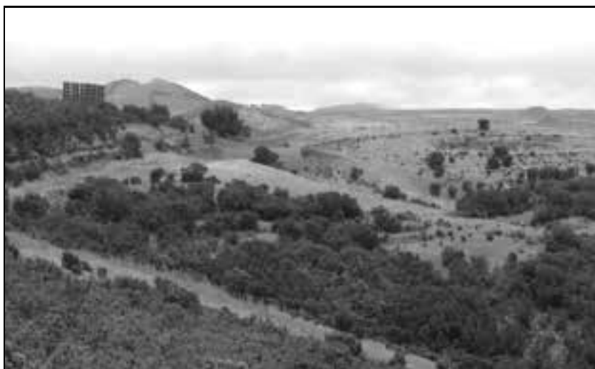
Fig. 29. Captación de agua procedente de la precipitación de niebla en las cumbres del Paisaje Protegido de Ventejís, muy cerca de la localidad histórica del mítico Garoé. La zona reúne, además, condiciones óptimas para llevar a cabo un proyecto de reforestación con flora autóctona. Ambientalmente fue ésta una de las ideas que más nos sedujo dentro de las estrategias de sostenibilidad perseguidas por el Plan Insular de Ordenación (PIOH).
